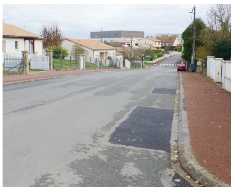
Rue des Cités : Réfection de trottoirs.
