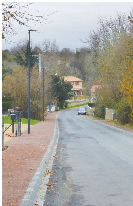
Rue du Moulin : Aménagement de trottoirs et amélioration de la gestion des eaux de pluie.
